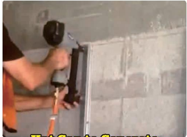
Hat Cap to Concrete
